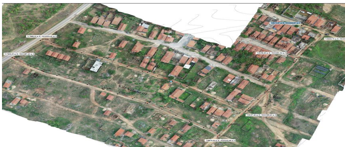
Foto: Ruas que serão pavimentadas.
